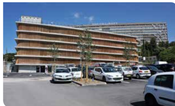
Marseille : parking Hôpital Nord
